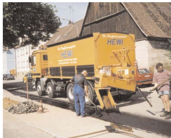
Der ATC "JUMBO" im Einsatz mit externer Förderschnecke (Foto: ATC A. Richter)
